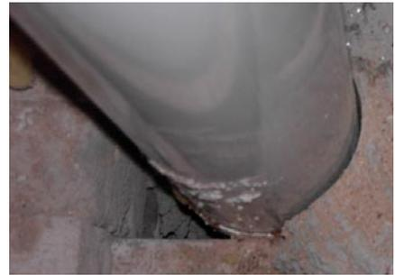
Klassische Gewährleistungsfall. Doppelwandige Abgasleitung ohne klassifizierten Abgasschacht. Betonierung im Deckenbereich führt zu einer höchst aufwändigen Demontage im worst case.
