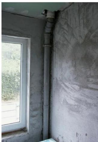
Einwandige Leitung hinter der Badewanne kraftschlüssig per Schelle fixiert. Hinterlüftung, Brandschutz, Längendehnung, einfache Demontagemöglichkeit – Fehlanzeige
