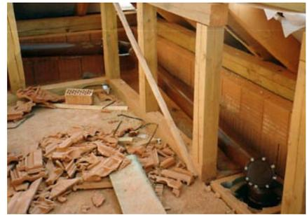
Wilde Verlegung einer Kunststoffabgasleitung. Platzsparende Verlegung mit einer Hand voll Mängel.
