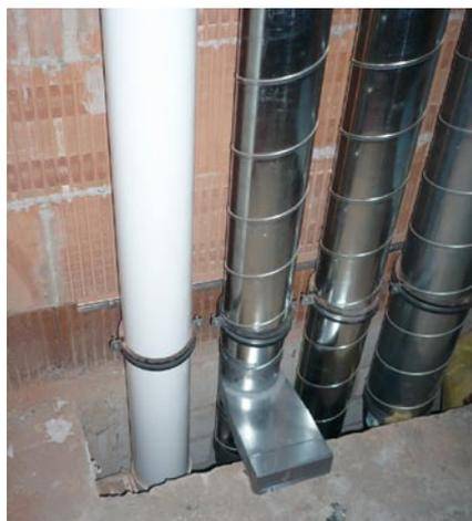
Doppelrohrsystem (LAS/AZ) im Installationsbereich ohne klassifizierten Schacht. Demontage der Abgasleitung nach Fertigstellung des Bauprojekts nur mit enormen Aufwand möglich.
