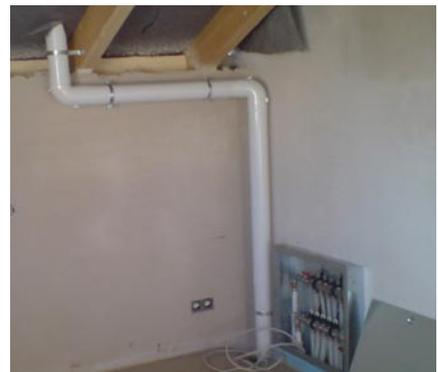
„Wildwest-Installation“: dem Auftraggeber wird ein sachmangelfreies Werk geschuldet, was hier nicht erfolgte. Fehlende einfache Demontagemöglichkeit, fehlendes Gefälle, Revision im Bogen mit stehendem Kondensat, Gipskartonverschlüsse sind für diese Anwendung nicht klassifiziert.
