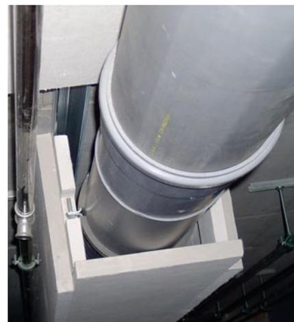
Einwandige Abgasleitung mit kraftschlüssiger Schellenverbindung. Erforderliche Längendehnung (bei 70K 1,1 cm/m) missachtet. Konstruktionsbedingt Demontage nicht möglich. Schacht mangelhaft.
