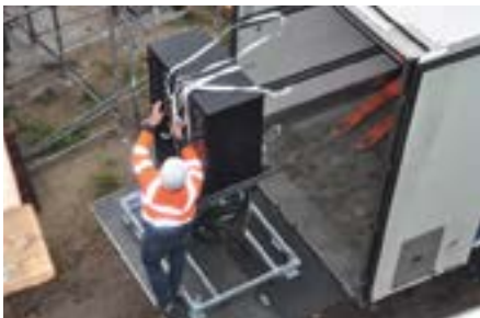
Abladen direkt auf der Baustelle.
