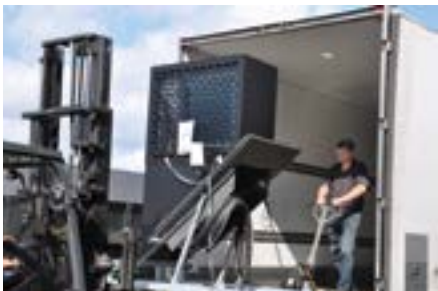
Verladen der vorgefertigten Einheiten.
