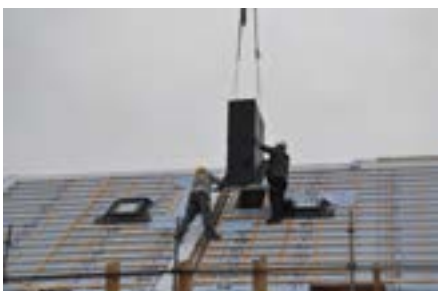
Fertigstellung auf dem Dach und Anschluss im Haus.
