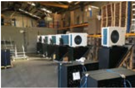
Vormontage der Wärmepumpen
