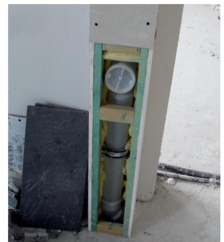
**Abb. 10: „Wildwest“-Installation.** Einwandige Abgasleitung, mit Schellen bauseitig kraftschlüssig befestigt. Jede Schelle stellt einen potenziellen Festpunkt dar! Rechts: fixierte einwandige Abgasleitung, nicht hinterlüftet, in „Verschlag“ aus Dachlatten und Gipskarton.
