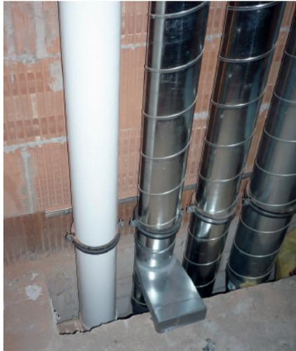
**Abb. 11: Doppelrohrsystem (LAS/AZ) im Installationsbereich ohne klassifizierten Schacht.** Eine Demontage der Abgasleitung nach Fertigstellung des Bauprojekts ist nur mit enormem Aufwand möglich.
