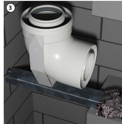
Auflageschiene evtl. kürzen und zusammen mit dem Stützbogen durch die Schachtöffnung in Bohrung einsetzen, ausrichten und fixieren (mit Schraube oder Mörtel).
